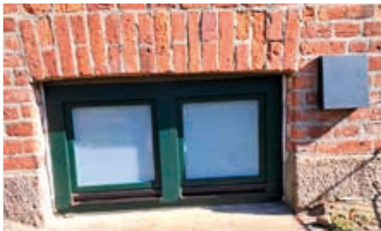
oben: neues Kellerfenster mit automatischer Belüftungsanlage
