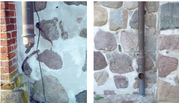
▲ Zum Vergleich: Kupferner Einlaufstutzen an der Nikolai-kirche in Kappeln mit unkonventionellem Plastikdeckel als Ersatz für gestohlenen Revisionsdeckel.
